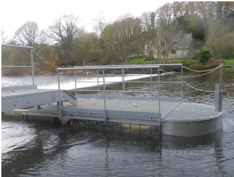
Photo n°8 : Vue amont du système de comptage après installation
