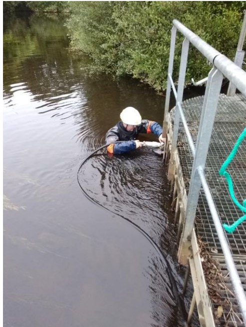
Photo n°10 : Intervention de découpe de la plaque de protection amont
